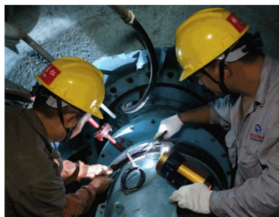
检修人员精心呵护电站和船闸设施设备安全运行
